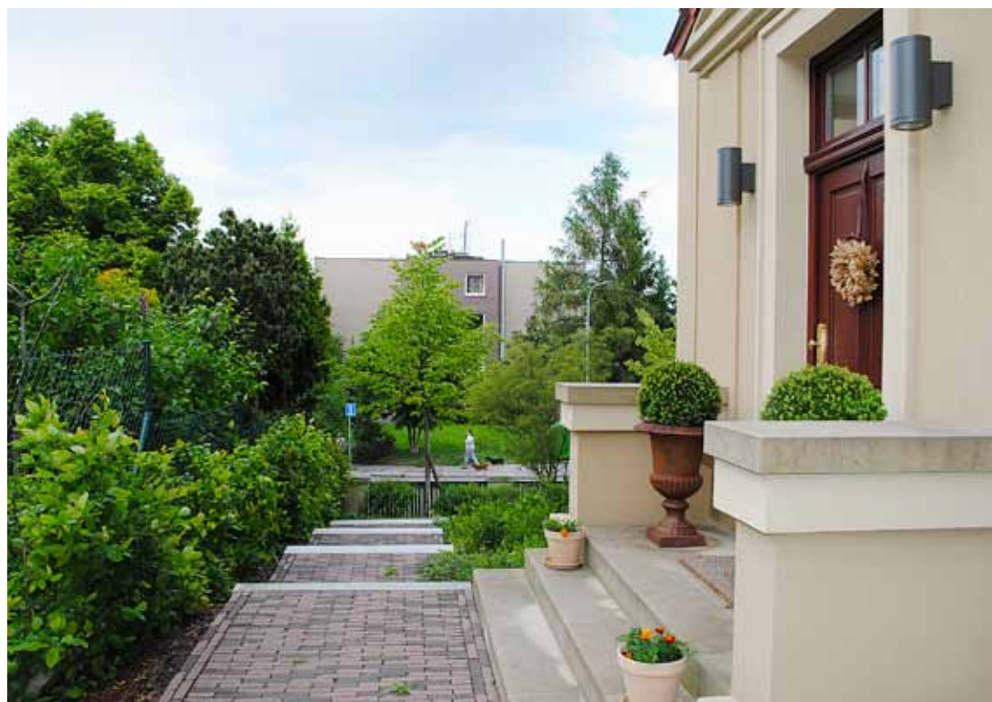
Vchod do domu byl při rekonstrukci posunut na úroveň patra. Je to jeden z nejdůležitějších prvků dané kompozice; nesmí zde chybět stálezelené rostliny ani ozdoba na dveřích
